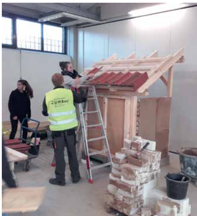
Teilnehmerin beim Dach eindecken
