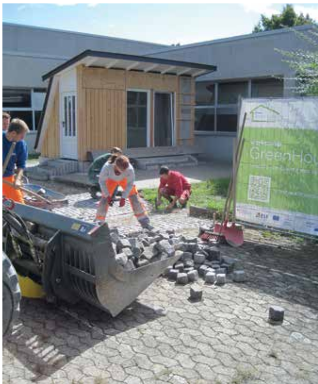
Pflasterarbeiten am GreenHouse
