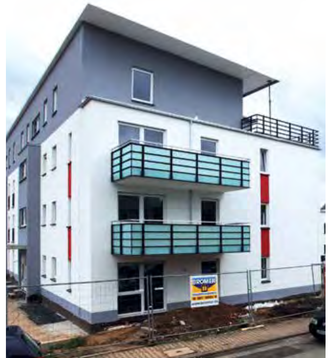
Wohnbebauung im Fliederweg, Frankfurt am Main, mit Mehrfamilien- sowie Reihenhäusern. Foto: F. Schuppelius
