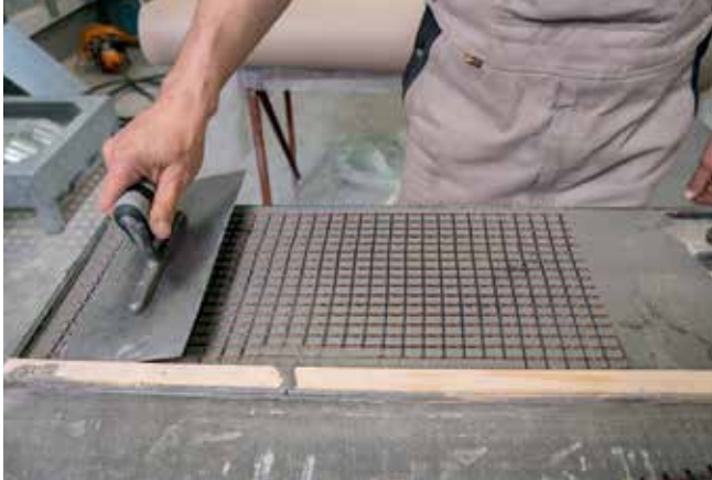
Betonage mit Carbonbewehrung
