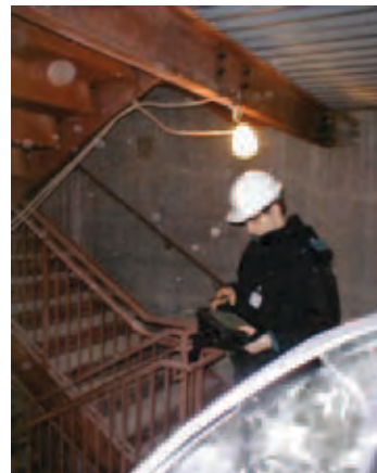
Bild 3: Nutzung eines mobilen IT-Systems im Rohbau
