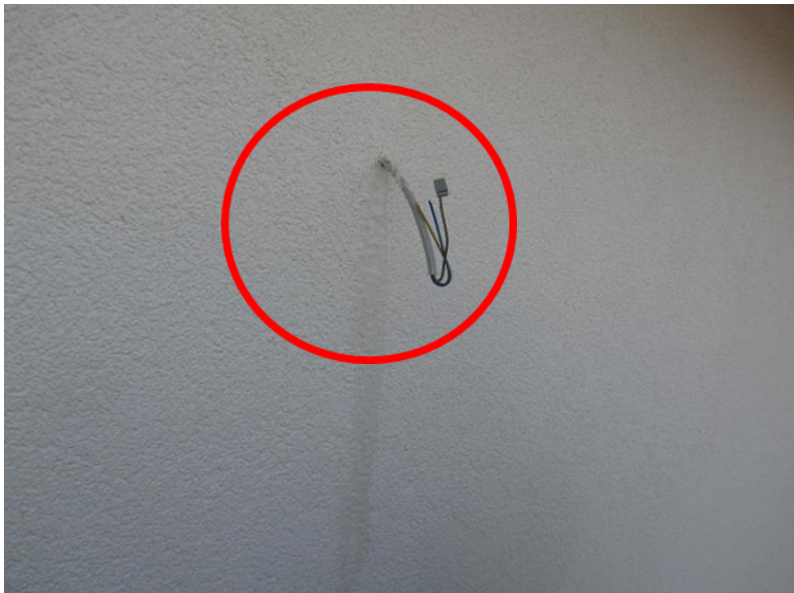
Wasser tritt aus der Fassade hervor
