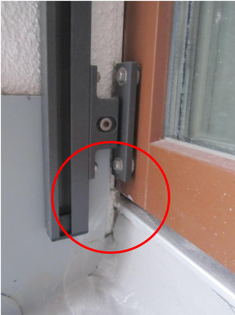
Fehlende Abdichtung des Türrahmens
