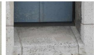
Abb. 2: Gefälle – erfordert keine Tropfkanten
