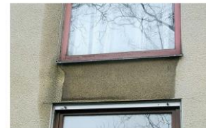
Abb. 1: Fassadenverschmutzung unterhalb Fensterbank
