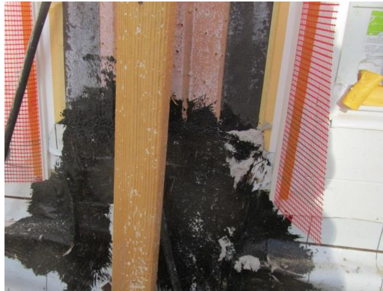
Fehlende Abdichtungsanschlüsse
