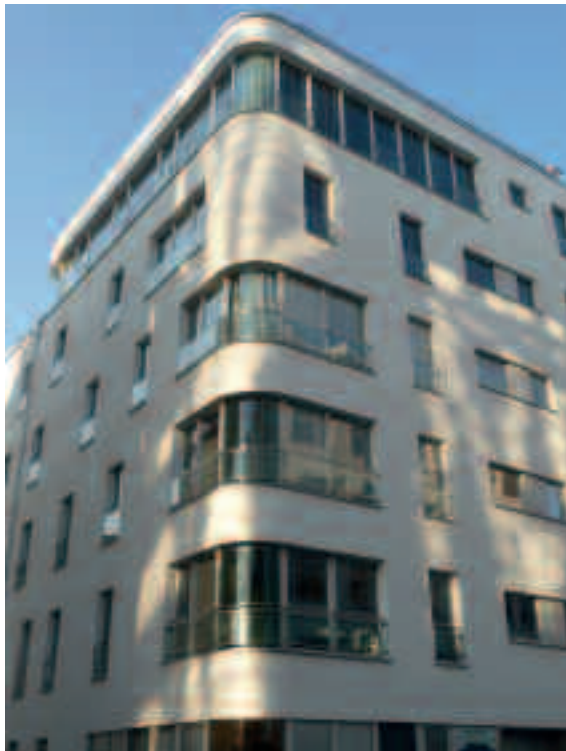
Pilotprojekt Dämmung mit VIP; Wohn- und Geschäftshaus, Seitzstraße München – Außendämmung mit VIP spart Platz auf teurem Baugrund
