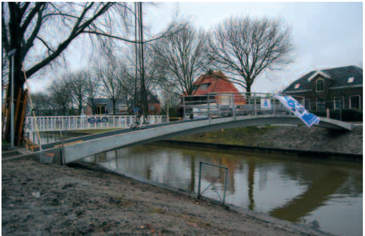
Anwendungen von UHPC in der Praxis: Ultraleichte monolithische UHPC-Fahrradbrücke (Gooisebrug, Utrecht) der Firma Romein Beton aus Holland, hergestellt mit einer individuell von g.tecz entwickelten C150 UHPC Rezeptur.
