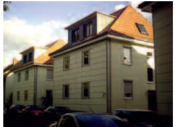
Wilhelmstraße in Hofheim – straßenseitige Vakuumdämmung ermöglicht die Einhaltung der Grundstücksgrenzen
