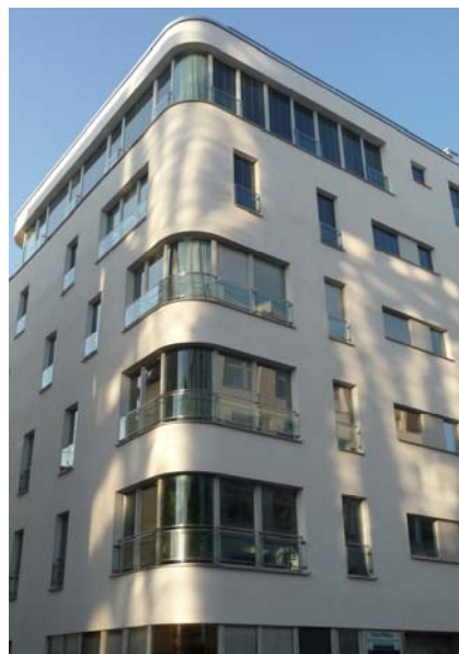
Bild 12: Pilotprojekt Dämmung mit VIP; Wohn- und Geschäftshaus, Seitzstraße München ((Architekt: Martin Pool, Foto: Ute Juschkus)
